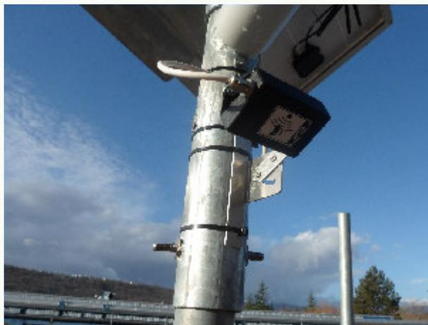
Opzionalmente si può montare un Radar che sfrutta l'effetto Doppler con due antenne integrate atte a rilevare i veicoli a motore in movimento ad alta velocità. Questo sistema è in grado di rilevare veicoli in avvicinamento, segnalando l'evento al sistema di controllo. Il sistema di controllo e comunicazione accende immediatamente l'intero impianto di illuminazione grazie alla rete di comunicazione presente su tutti i poli.
