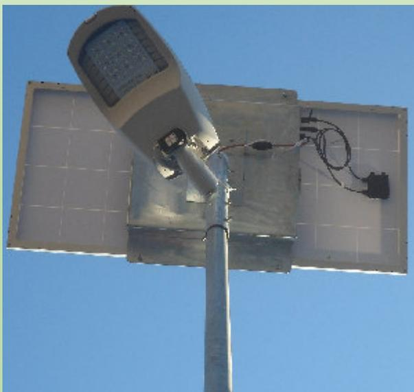
E' possibile orientare il pannello fotovoltaico verso sud e orientare perfettamente la lampada sulla strada grazie allo speciale snodo che permette la rotazione di 360°. La raccorderia, il giunto e la struttura ad omega sono realizzati in acciaio Fe360 con finitura zincata a caldo. Le viti, gli inserti, i dadi, i bulloni e le rondelle sono realizzati in acciaio inossidabile.
